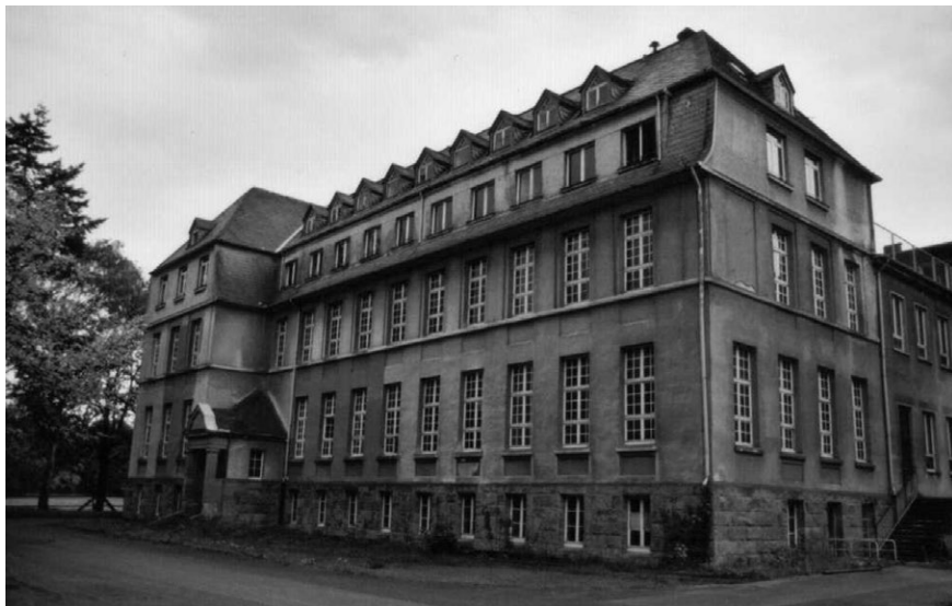
Abb. 32: Das „Schutzengelhaus“, in dem 1941 die Kinderfachabteilung Waldniel eingerichtet wurde, Foto aus dem Jahr 2004
