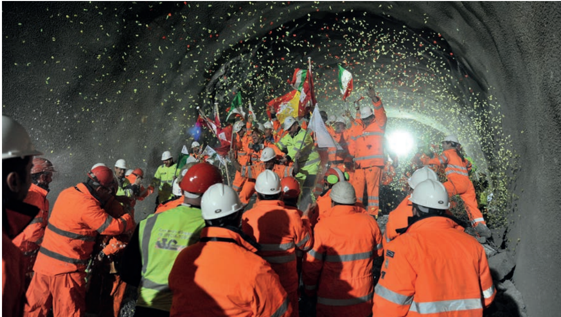
Hauptdurchschlag in der Weströhre des Ceneri-Basistunnels am 21. Januar 2016
