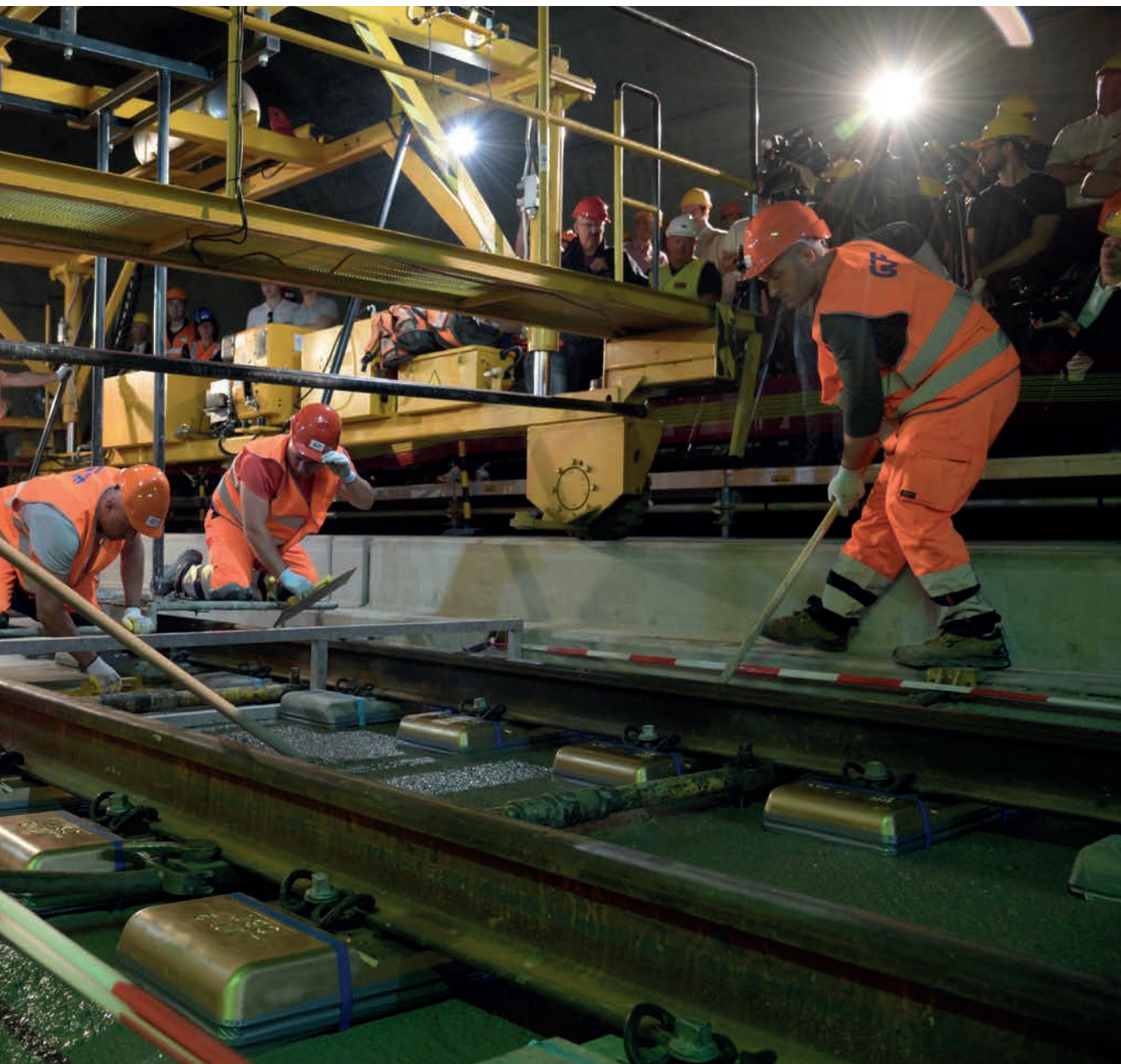
Am 30. Mai 2018 wurden im Ceneri-Basistunnel die letzten Gleise verlegt.
