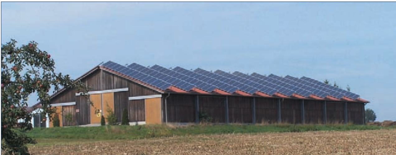
Abb. 5.6 – Ausführungsbeispiel einer Solaranlage, bei der die Solarmodule an einer speziellen Stahlkonstruktion montiert sind, und die im Sinne einer optimalen ganzjährigen Energieausbeute gegen die sommerliche Laufbahn der Sonne ausgerichtet sind
