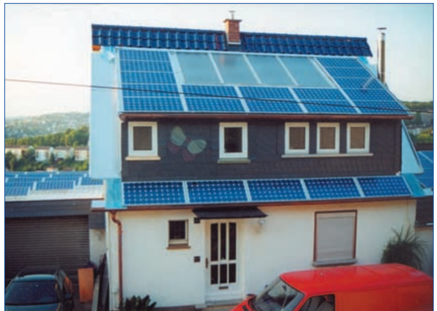
Abb. 5.4 – Solarthermische Dachmodule (oben Mitte) unterscheiden sich nur wenig von solarelektrischen Modulen und können auf dieselbe Weise auf Dächer montiert werden (Foto Schüco)
