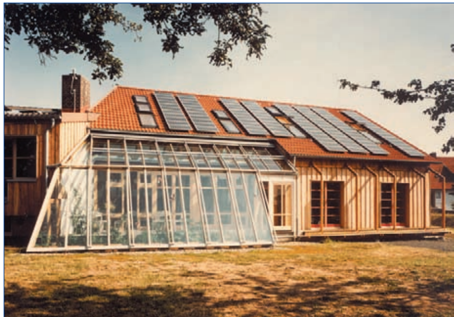
Abb. 5.2 – Die geometrische Einteilung der Solarmodule am Dach bleibt dem Hausbesitzer überlassen und unterliegt normalerweise keiner behördlichen Anordnung (Foto Siemens)
