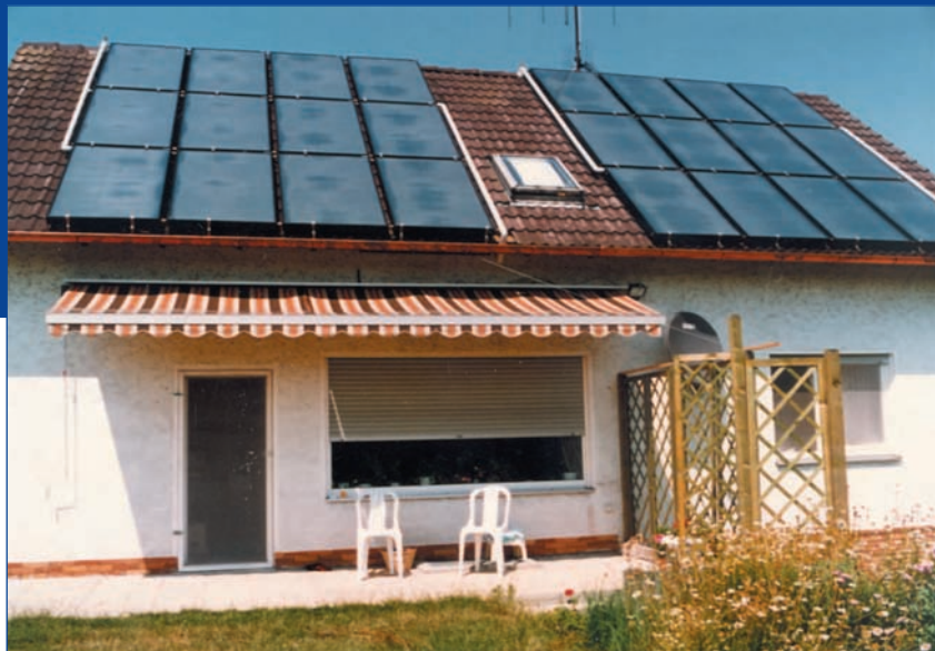
Abb. 3.1 – Kleinere thermische Solarkollektoren am Hausdach werden als einzelne Module auf eine beliebige Art und Weise auf dem Dach zusammengestellt und meist zum Aufwärmen von Trinkwasser im Warmwasserbehälter genutzt (Foto Sunset-Energietechnik)
