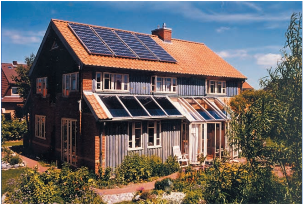
Abb. 5.1 – Eine Dachfläche, die kompassgenau gegen den Süden ausgerichtet ist und einen Neigungswinkel von etwa 30° bis 40° hat, eignet sich für das Anbringen von Solarmodulen optimal (Foto Siemens)
